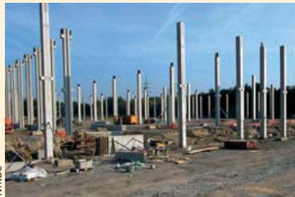
Het distributiecentrum wordt gebouwd op vroegere gronden van buur Komatsu.
